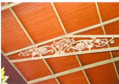
Detalles de la estructura interior, en hierro forjado, con motivos ornamentales
