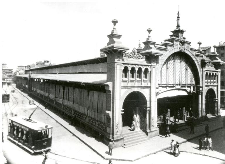
piedra de Floresta (Tarragona), mientras que para las labores de molduraje y torneado dejó de utilizarse la de Ainzón, sugerida en el proyecto, sustituyéndose por la procedente de las canteras de La Puebla. Para la ejecución de otro tipo de piezas como plintos y basamentos sencillos el material utilizado fue la piedra de Calatorao.
